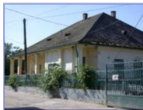
4. Sajó Agrár Rt. épülete /hrsz.: 335/
