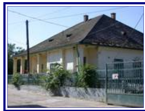
4. Sajó Agrár Rt. épülete /hrsz.: 335/
