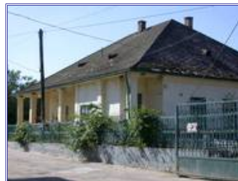
4. Sajó Agrár Rt. épülete /hrsz.: 335/
