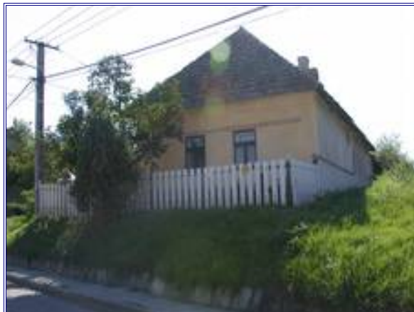
6. Rákóczi utcai lakóház /hrsz.: 300/
