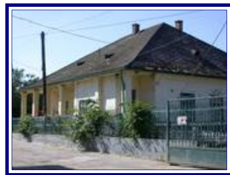
4. Sajó Agrár Rt. épülete /hrsz.: 335/
