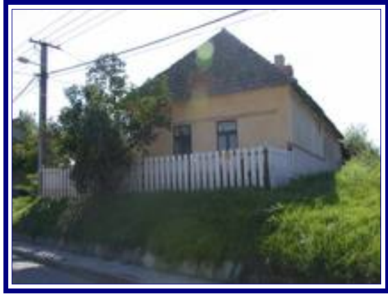
6. Rákóczi utcai lakóház /hrsz.: 300/
